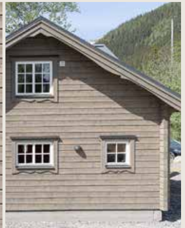
Profilerad foderbräda under fönster och profilerade vindskivor.
