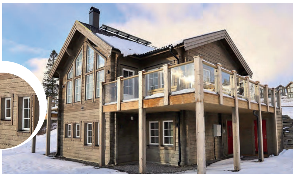
Souteränghus med timmerbeklädning samt knutar, foder och salning för concellvägg (prefab betong). Bild: @skistar
